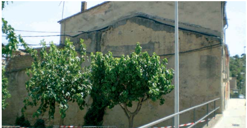
LATERAL DE L'EDIFICI QUE HA ADQUIRIT RECENTMENT L'AJUNTAMENT
