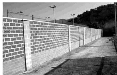
EL MUR TÉ UNA LONGITUD DE MÉS DE 54 METRES
