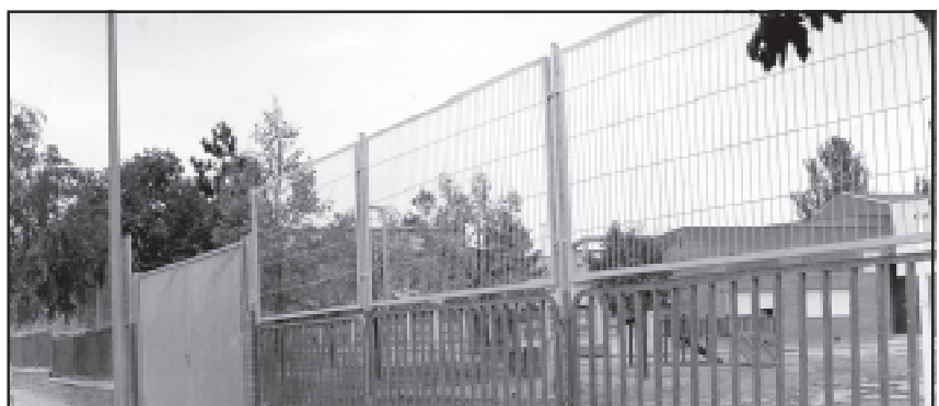
La tanca que s'ha col·locat és de malla galvanitzada
