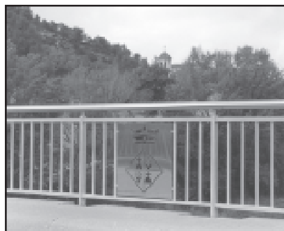
El nou pont té uns escuts del municipi
