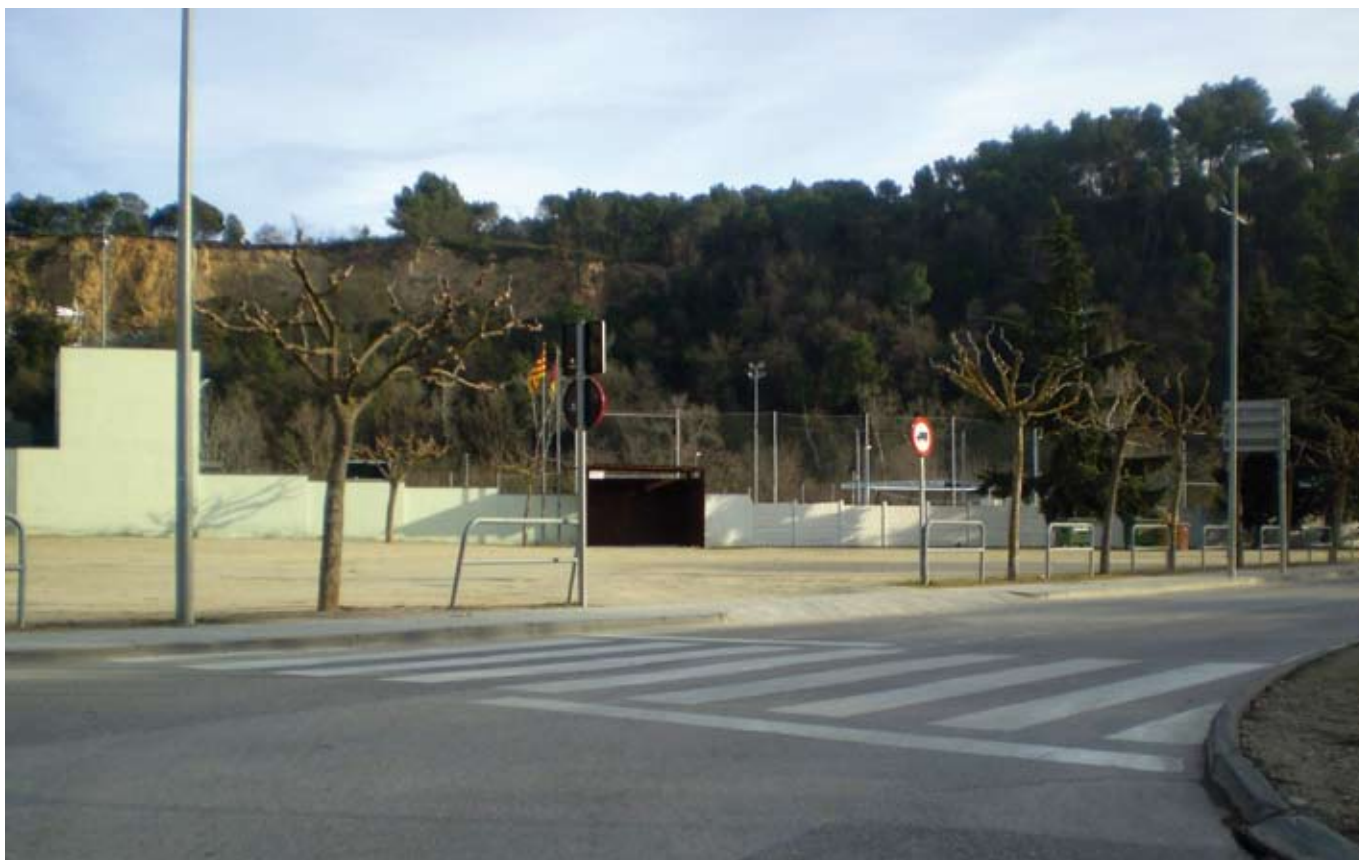
IMATGE ACTUAL DE LA CARRETERA DE LA RATA I DEL PÀRQUING DE LA ZONA ESPORTIVA DEL PAS BLAU
