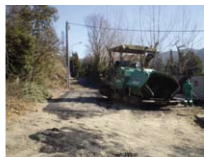
TREBALLS D'ASFALTATGE AL CAMÍ VELL DELS VIVENCS
