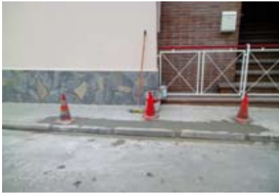
REPARACIÓ D'UNA VORERA DEL CARRER DE SOLDEVILA
