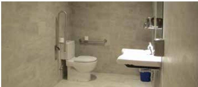
ELS SANITARIS DE L'ATENEU, UN COP REALITZADES LES OBRES
