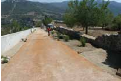
S'HA CIMENTAT EL VIAL DE SERVEI PER FACILITAR L'ACCÉS DE VEHICLES
