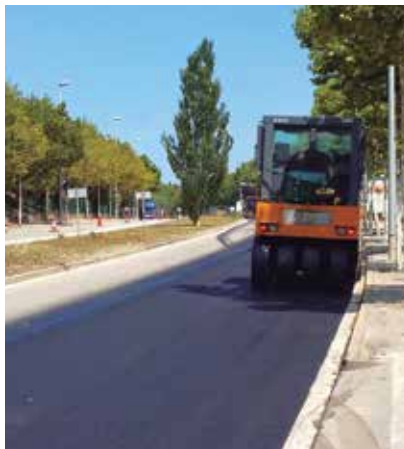
TREBALLS D'ASFALTATGE AL POLÍGON DELS PLANS D'ARAU
