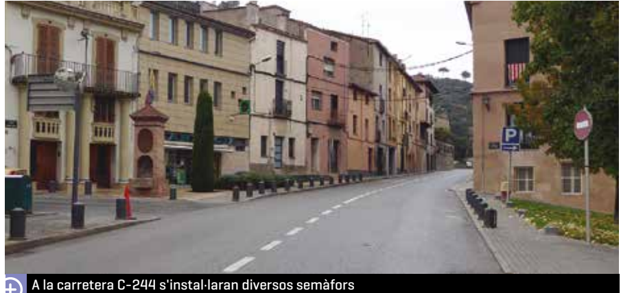
A la carretera C-244 s'instal·laran diversos semàfors
